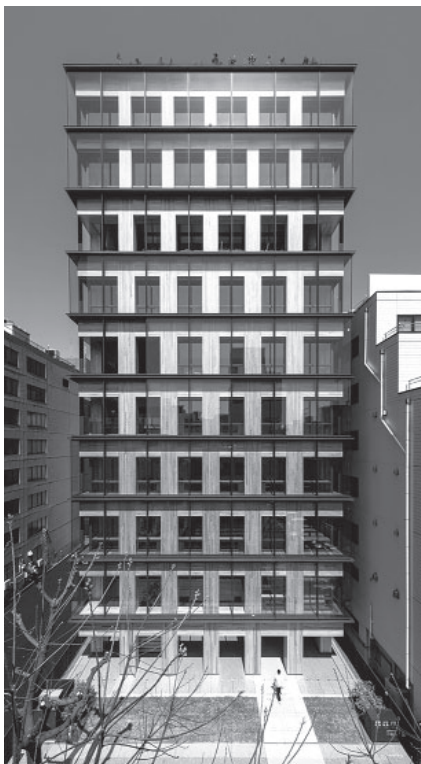
高層純木造耐火建築物
