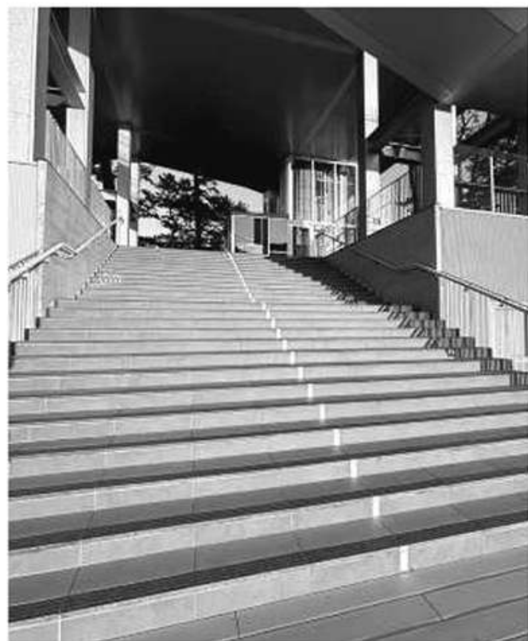
土肥地区の避難タワーの階段
