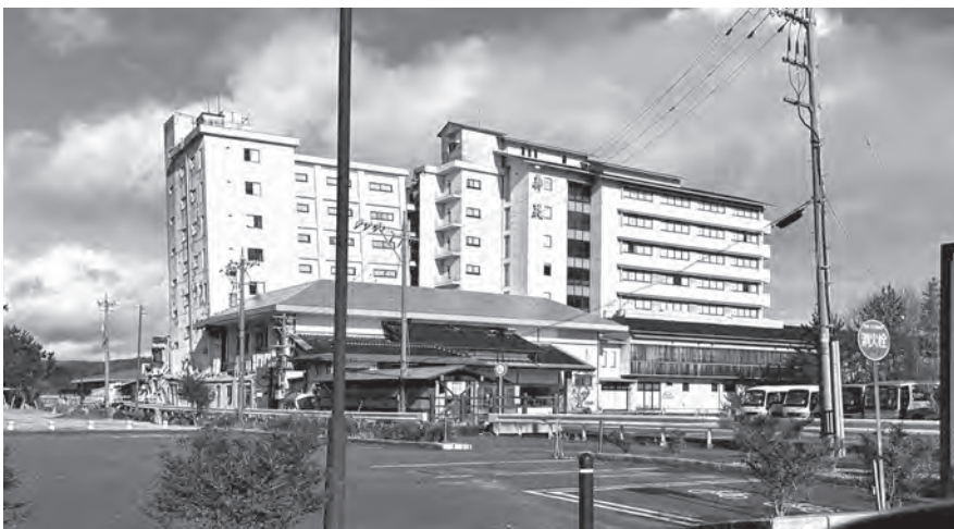
地震により傾いた建物
